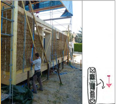
Phase 1(a) / compression par niveau effectué entre poutre-caissons (lisses) par sangles objectif: plan horizontal permettant pose plancher
