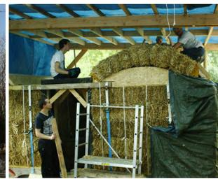
Cellier: montage de la toiture en entre-vous [petite botte, 120 kg/m3 PA, enduit terre], 2017
