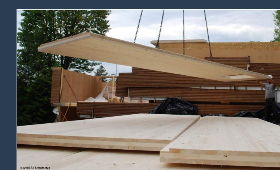
Levage panneaux (CLT)
