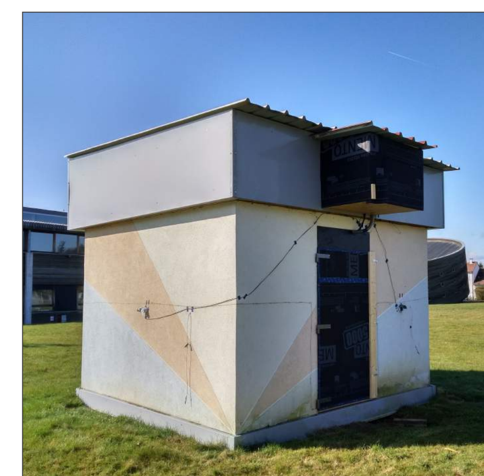
Cellule test en CLT
